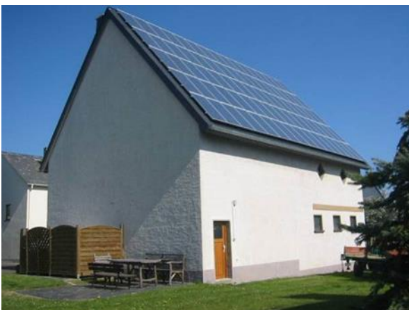
Abb. 2-49: Empfehlenswerte Integration einer PV-Anlage in das Dach (Stadt-Land-plus 2018)
